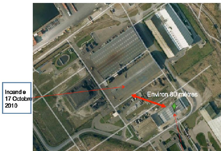
Installation de traitement des Lampes
